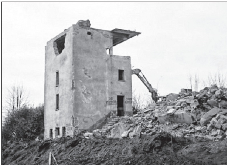
Ryc. 4.5. Rozbiórka nastawni wykonawczej „Ch2” w 2010 roku.
