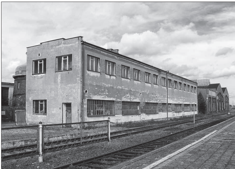
Ryc. 4.9. Budynek socjalno-warsztatowy przy peronie nr 3 w 2017 roku.
