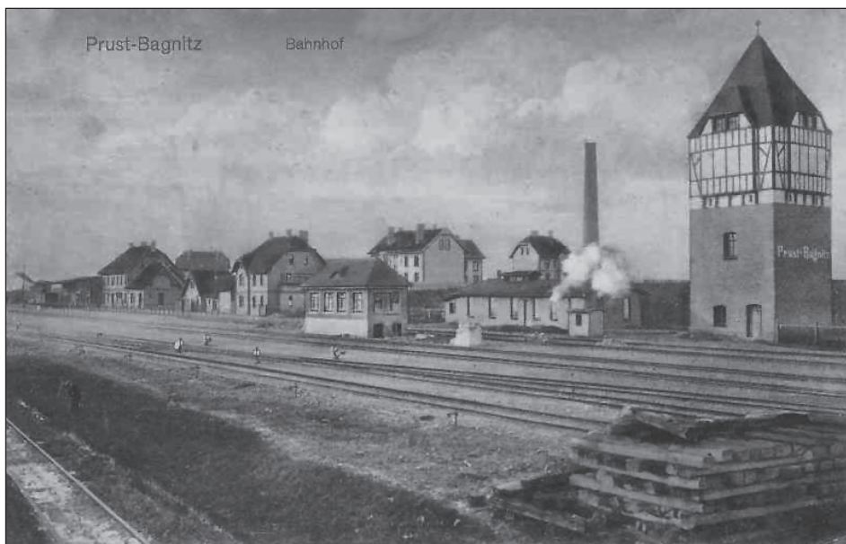
Ryc. 1.7. Stacja węzłowa Pruszcz Bagienica.
