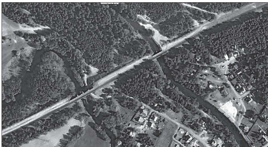
Ryc. 1.9. Zdjęcie satelitarne okolic Rytle. W okolicy mostów widoczne pozostałości robót ziemnych trzeciego korytarza transportowego.
