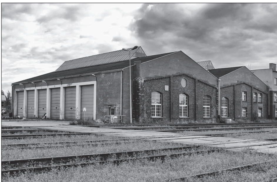
Ryc. 4.17. Stara hala parowozowni po przebudowie.
