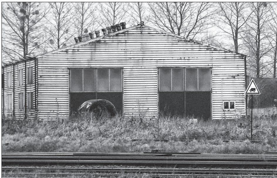
Ryc. 4.11. Hala wagonowni w Chojnicach.
