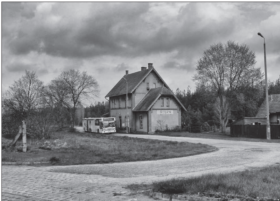
Ryc. 5.7. Dworzec na stacji Osieczna przy nieczynnej linii nr 218.
