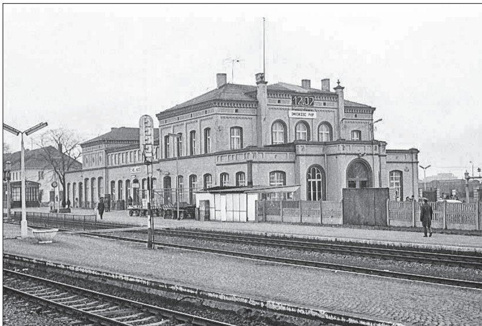
Ryc. 4.10. Chojnicki dworzec z nowym zegarem elektronicznym.
