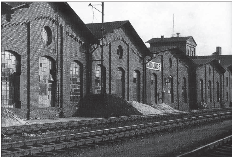
Ryc. 4.16. Pięciosegmentowa hala parowozowni przed rozbiórką w 1996 roku.
