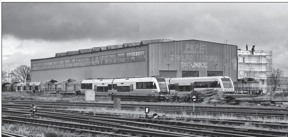
Ryc. 4.15. Hala napraw taboru widziana od strony ulicy Towarowej.
