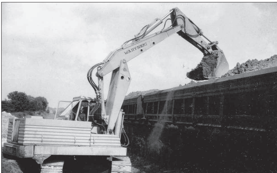
Ryc. 4.14. Załadunek urobku na wagony samowyładowcze typu 904V przy budowie drugiego toru na szlaku Wapno – Kcynia.
