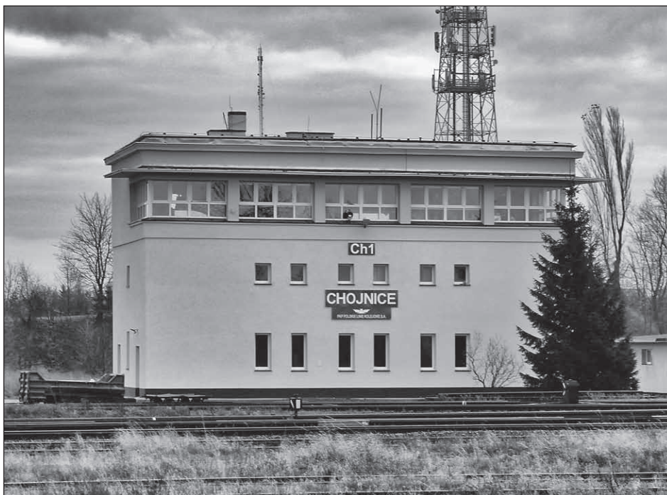
Ryc. 4.4. Nastawnia wykonawcza „Ch1” po remoncie w 2017 roku.
