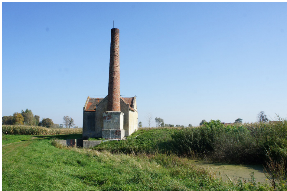
Ryc. 3. Historyczna przepompownia w Różanach.
