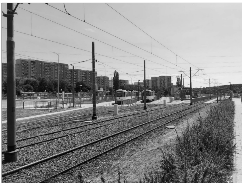
Ryc. 4. Pętla Turkusowa - koniec I etapu budowy Szczecińskiego Szybkiego Tramwaju.
